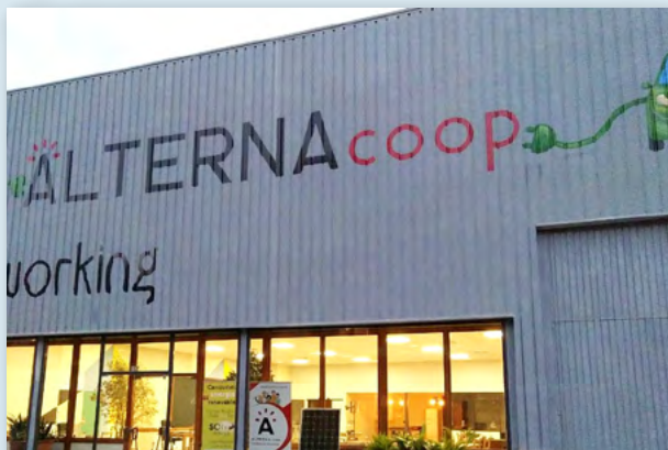
La cubierta del "eCoworking" de Alterna Coop ya acoge la primera instalación de Sapiens energía en Albalat dels Sorells. Tiene 68,85 kWp de potencia instalada y 23 kWp de almacenamiento. Permite abastecer de energía renovable a más de 60 hogares, varias empresas y edificios públicos.
